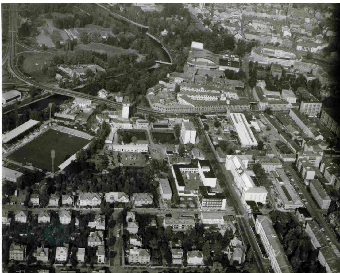
Obrázek 13: Letecký pohled na Krumlovské (Linecké) předměstí, přes ulici Mánesova je i vidět bývalý areál továrny (dnes supermarkety Billa a Lidl). 1991. Zdroj: SOKA České Budějovice.F9, 7831.
