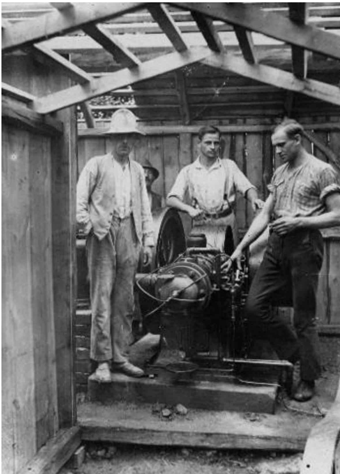
Obrázek 15: První naftový motor 12 HP. Bedřich Čížek je uprostřed. Rok 1928.
