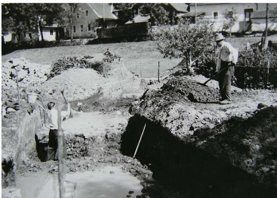
Obrázek 18: Budování nového koryta odtoku vody od turbíny v roce 1939.
