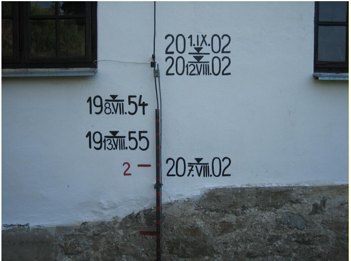
Obrázek 24: Výšky hladin povodní na západní zdi Křemežské elektrárny.
